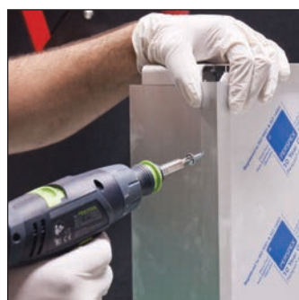
FISSAGGIO CORNICE ANGOLARE
